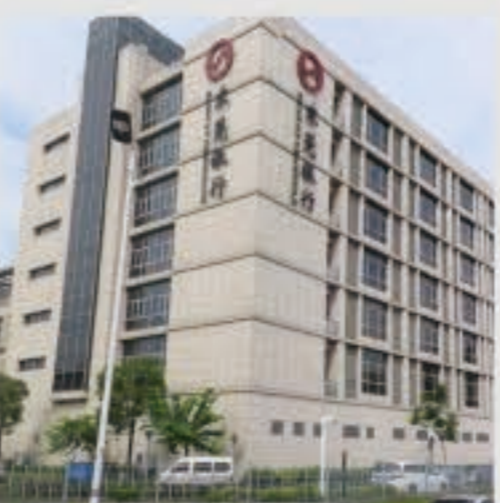
东莞银行数据中心 项目时间: 2016/11/25
